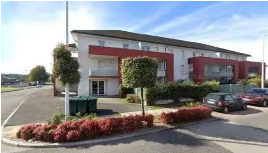
Sadem etancheite toiture terrasse artix pau oloron orthez tarbes street view et 360deg
