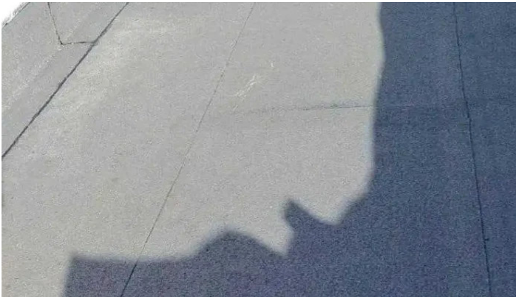
Sadem etancheite toiture terrasse artix pau oloron orthez tarbes tout
