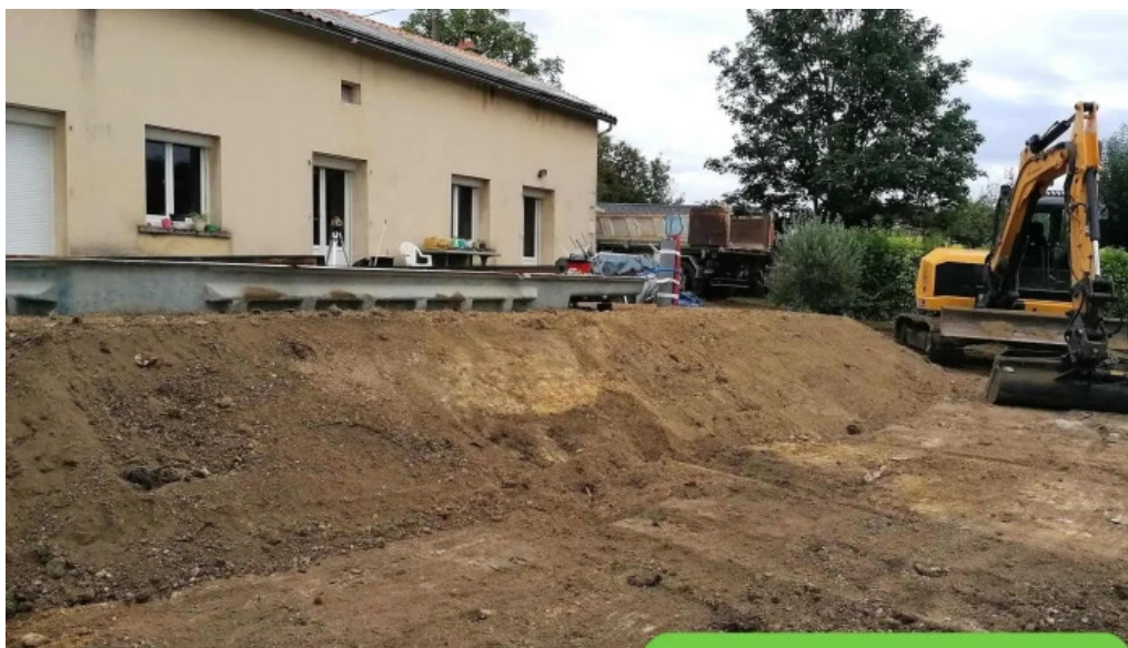
Arb terrassement photos du proprietaire
