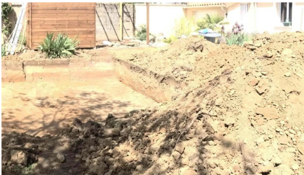
Arb terrassement adresse
