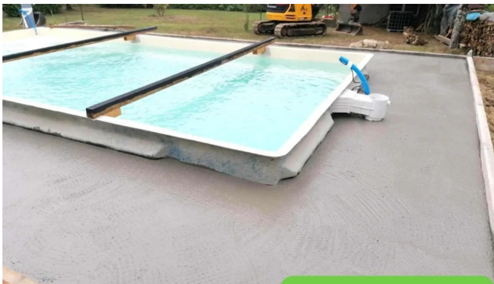
Arb terrassement interieur
