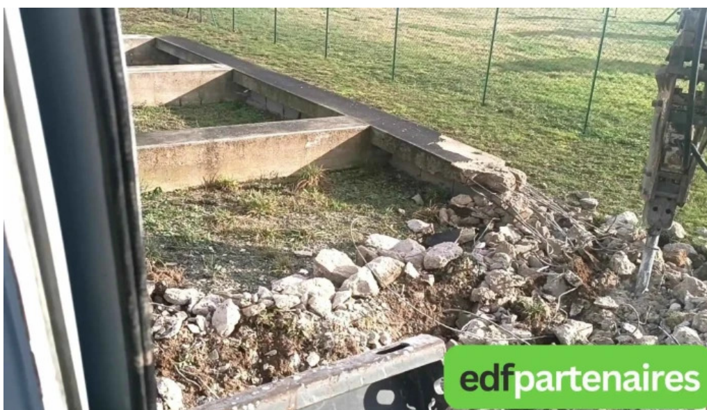
Arb terrassement les plus recentes
