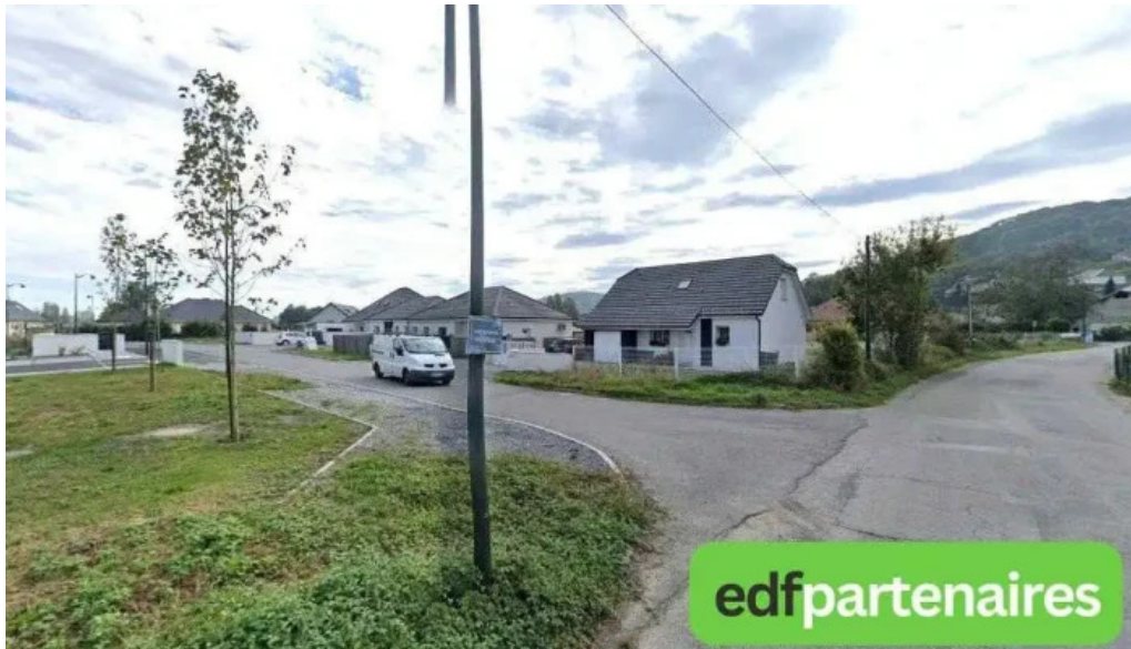
Pst clim chauffage climatisation sanitaire arbus
