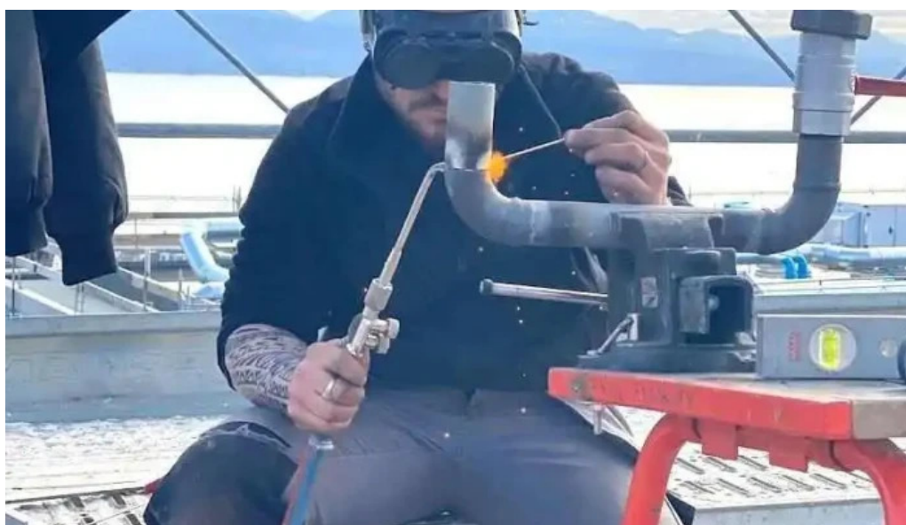
Beau energie plombier perigueux razac sur l isle
