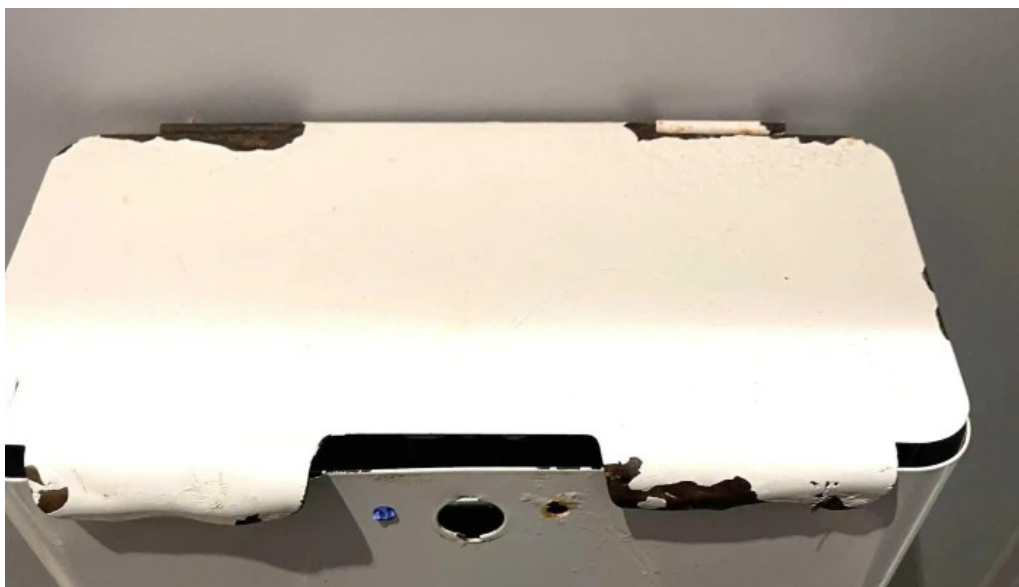
Station eni a64 nord pk815 aire de lacq audejos nord photos
